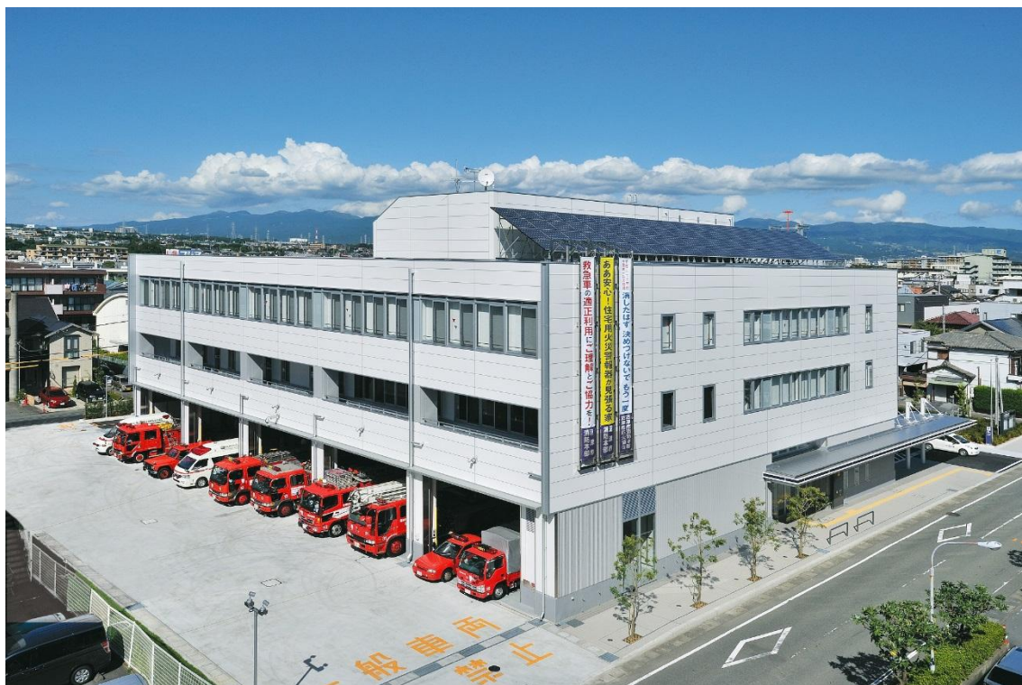
駿東伊豆消防本部（沼津市）
