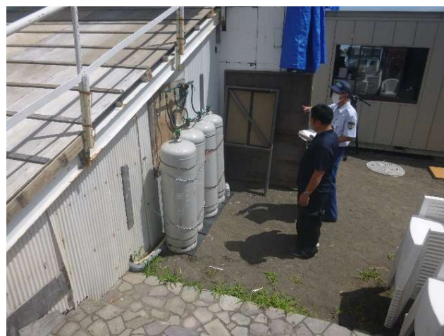
LPGボンベの設置状況の確認
