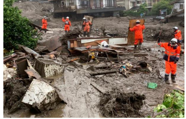
④ コンパネを敷き足場を確保しての活動
