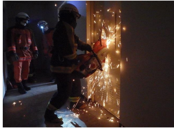
【開口部の破壊の様子】
