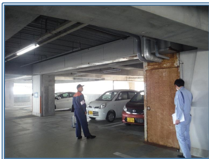
防火設備の作動障害が無いか確認を実施
